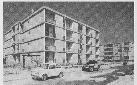
Bild 3. Wohnhäuser, wie sie in Israel mit vorfabrizierten Elementen, System «Rastrom», erstellt werden
