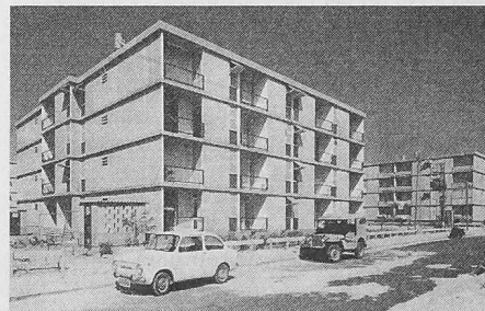
Bild 3. Wohnhäuser, wie sie in Israel mit vorfabrizierten Elementen, System «Rastrom», erstellt werden
