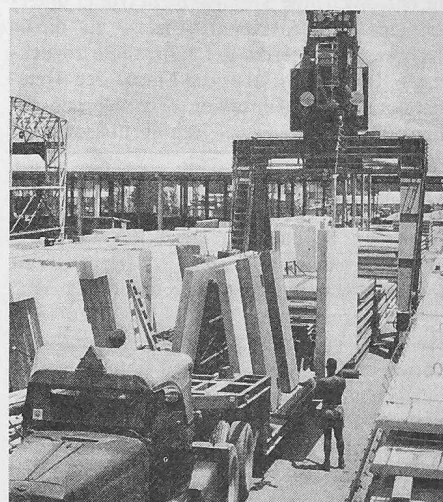
Bild 2. Lagerung und Abtransport der Fertigbauteile
