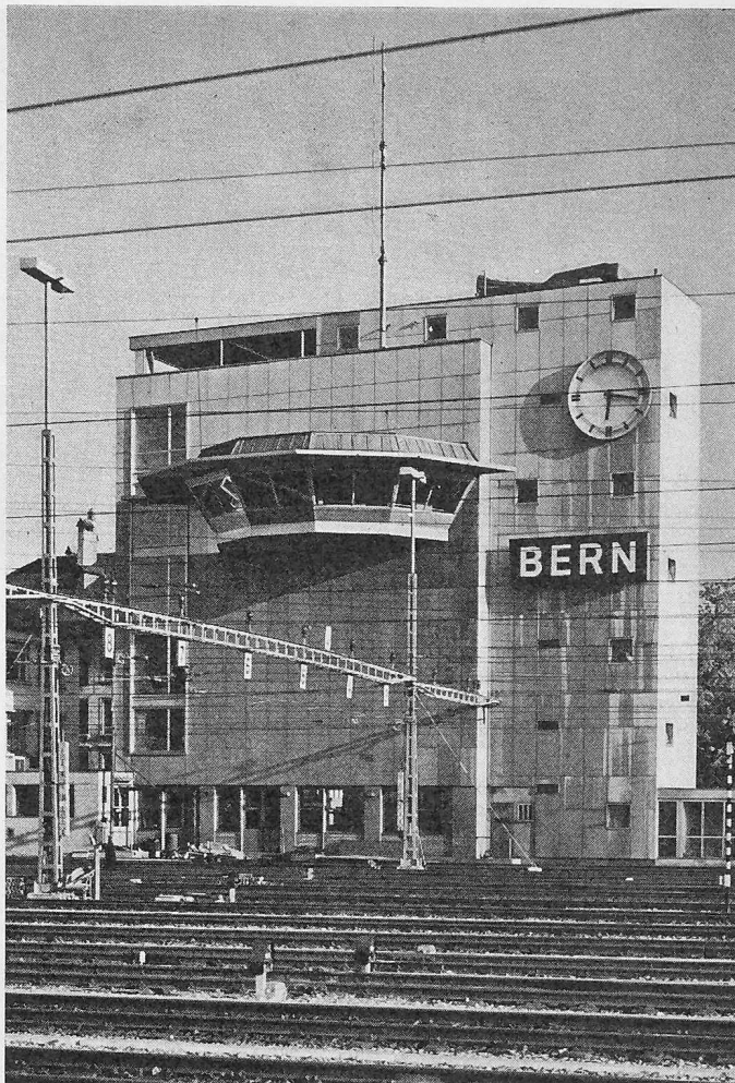
Bild 7. Das Befehlsstellwerk («Stellwerk 1» in Bild 4)
