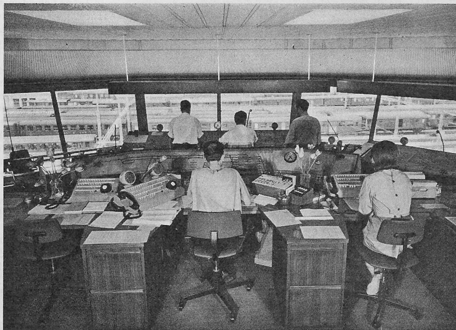
Bild 9 (rechts). Kommandoraum im Befehlsstellwerk
