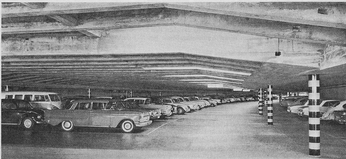
Bild 17. Blick in ein Geschoss der Autoeinstellhalle «Parkterrasse Grosse Schanze»
