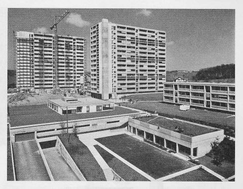
durch enge Zusammenarbeit zwischen Architekt, Ingenieur und Unternehmer möglich. In Worblaufen kamen zum erstenmal vorgefertigte Backstein-Mauertafeln als tragende Wände von Hochhäusern zur Anwendung.
