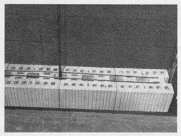
Bild 3. Preton-Steine mit Transportarmierung an der Montagewand
