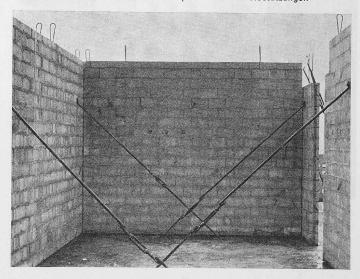
Bild 8. Fertig verputzte Preton-Wand
