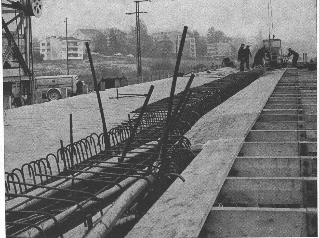
Brücke Oetwil a. d. Limmat, Teillieferungen an: Conrad Zschokke AG, Zürich
