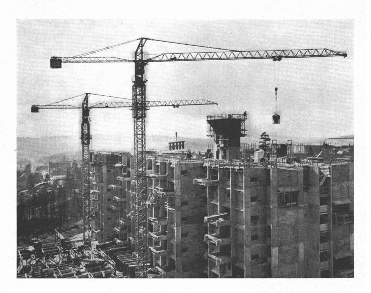
2500 Krane pro Jahr. 40 verschiedene Modelle von 250 kg bis 45 Tonnen. 5 bis 47 m Ausladung. Grösstmögliche Standardisierung. Geschlossene Oelbadgetriebe für Hubwerk und Fahrwerk. Kein Auswechseln von Motoren. Auf Wunsch Hubwerk mit 20 verschiedenen Geschwindigkeiten.
