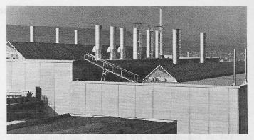
Bild 4. Dach des Schmiedegebäudes mit den Abgaskaminen der Oefen (mit Hut) und den Abluftkaminen der Lüftung (ohne Hut). Im Hintergrund das Hochkamin der Kehrichtverbrennung Winterthur
