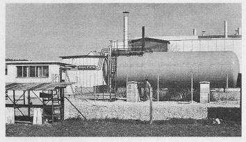
Bild 2. Propanbehälter. Links Apparatehaus, oben Sicherheitsventile und Auspuffleitungen
