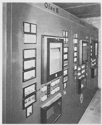
Bild 7. Steuer-, Regel- und Mess-Schrank für die Schmiedeöfen
