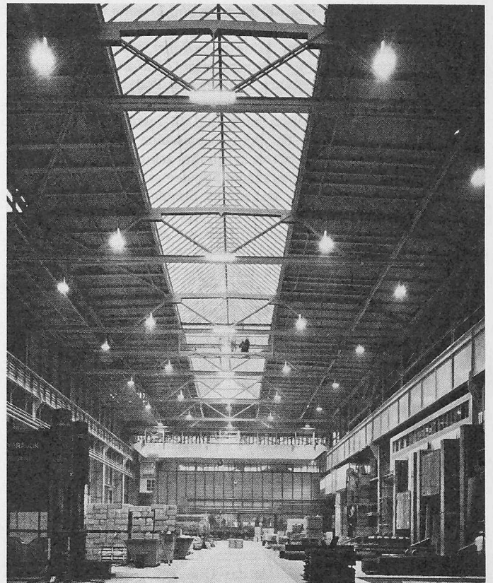
Bild 8. Beleuchtungseinrichtungen in der Pressehalle 3
