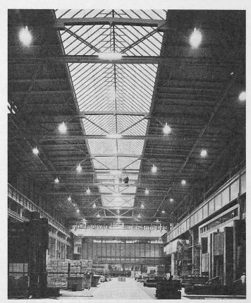
Bild 8 Beleuchtungseinrichtungen in der Pressehalle 3
