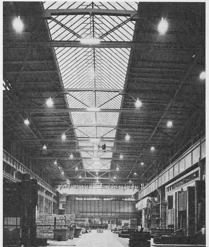
Bild 8. Beleuchtungseinrichtungen in der Pressehalle 3
