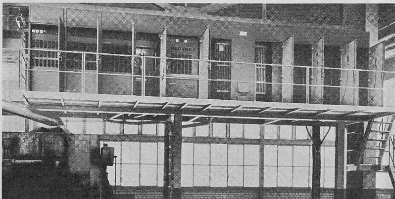
Bild 3. Blocktransformatorenstation im Zwischenfeld der Hallen 1/2
