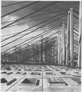
Bild 5. Die Dachplatte besteht aus vorfabrizierten Elementen von 1,55 m Breite und 4,98 m Länge
