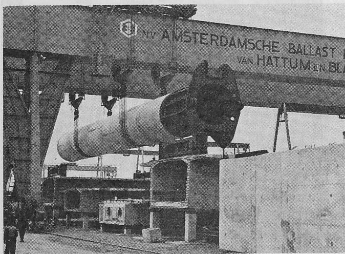
Bild 16. Transport eines Pfahles über das Werkareal
