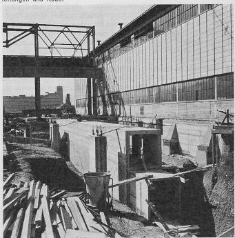
Bild 3. Montage der Stahlkonstruktion, vorn die Pressehalle
