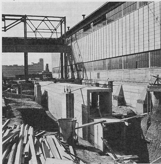
Bild 2. Personendurchgang mit darunterliegendem Durchgang für Rohrleitungen und Kabel
