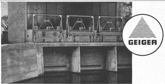
RECHEN- UND SIEBANLAGEN ZUR BRAUCHWASSERREINIGUNG Feststehende Grobrechen Bauart Geiger mit maschineller Reinigung mittels Harke dienen zur Zurückhaltung von Sperrstoffen aus Wasser und Abwasser und haben sich seit Jahrzenten im angestrengten Dauerbetrieb unter allen Verhältnissen bewährt ■ Die Abbildung zeigt drei Grobrechen für ein Groß-Kraftwerk.
