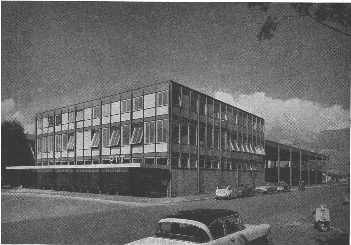
PTT-Betriebsgebäude Buchs/SG dipl. Architekt W. Gantenbein, Zürich und Buchs Sichtbare unverkleidete Stahlkonstruktion Fassadenstützen aus I-Profilen Sturzträger aus gepressten Blechen
