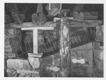
Bild 8. Scheitelknick des Kabels VII. Man sieht den schlechten Zustand des Bruchsteinmauerwerkes und die Gipssiegel zur Beobachtung der Risse
