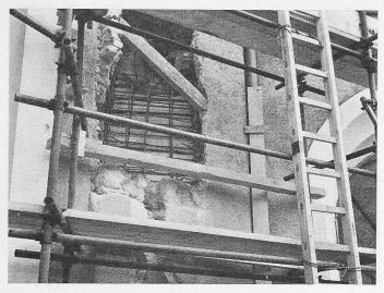
Bild 7. Umlenkstelle des Kabels VII. Mauerschlitz und Bohrung von aussen gesehen. Armierung des lastverteilenden Betonsattels
