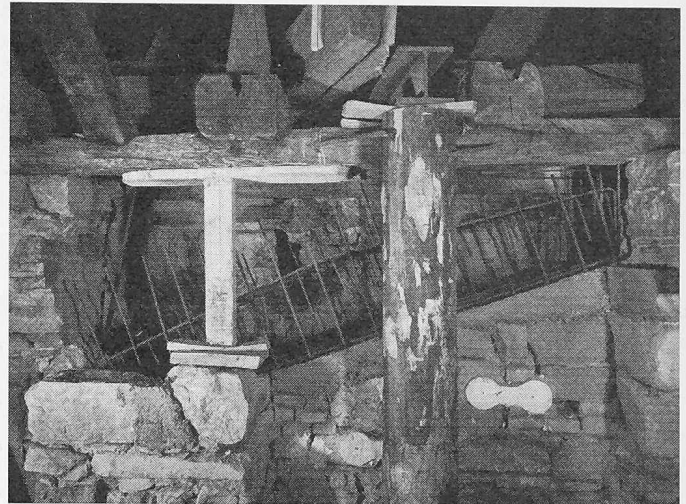
Bild 8. Scheitelknick des Kabels VII. Man sieht den schlechten Zustand des Bruchsteinmauerwerkes und die Gipsiegel zur Beobachtung der Risse
