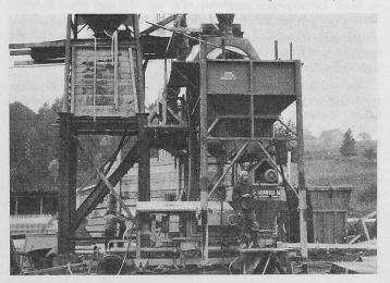
Bild 4. Einbringen des Betons mit einem 6 m langen, flexiblen Schlauch
