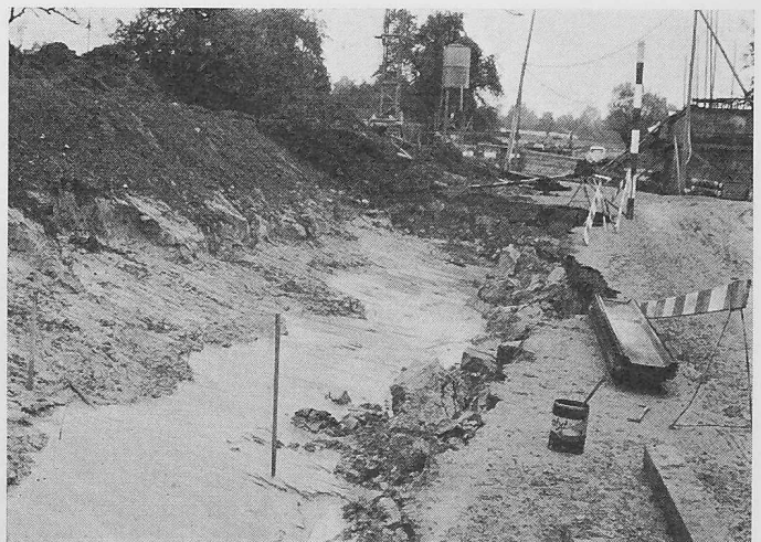
Bild 7. Ausschwemmungen an einer geschichteten Wechsellagerung Silt — Feinsand unter Moräne, vor dem Anlaufen der Sanierungsmassnahmen. Andwilerstrasse nördlich von Mettendorf
