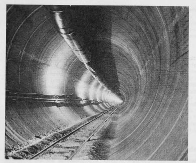
Bild 10. Ansicht des gebohrten Tunnels von 6,05 m Bohrdurchmesser. An der Kalotte Abluftlutte, am Parament Wasserleitung, 2300-V-Hauptkabel für die Stromversorgung der Vortriebsmaschine und Speisekabel der Tunnelbeleuchtung
