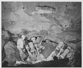
Bild 8. Durchbohren des Navajo-Tunnels 1 in die Energievernichtungskammer des Einlaufbauwerkes
