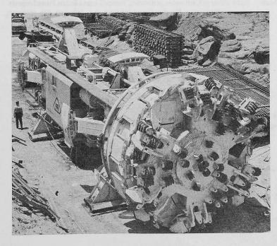
Bild 4. Vordere Fussplatten des äusseren Rahmens mit den zugehörigen hydraulischen Pressen, darüber Kupplungsgehäuse (Werkstattaufnahme)
