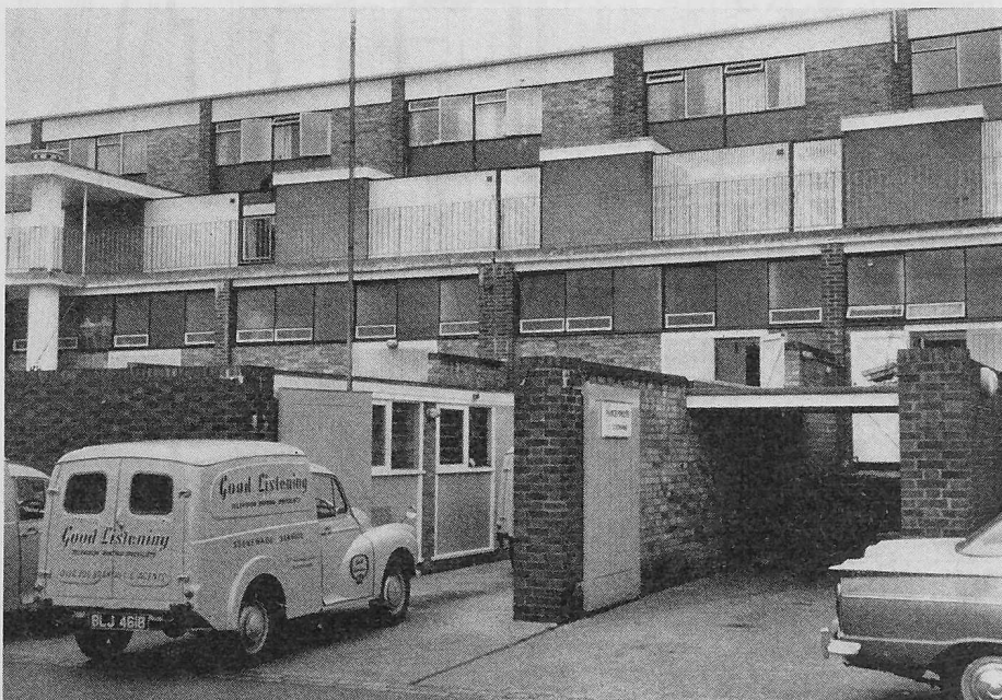
Bild 9. Einkaufszentrum Stevenage: Frachtfahrt von hinten, Lager im ersten Obergeschoss, darüber Wohnungen für Ladenbesitzer oder Geschäftsleiter
