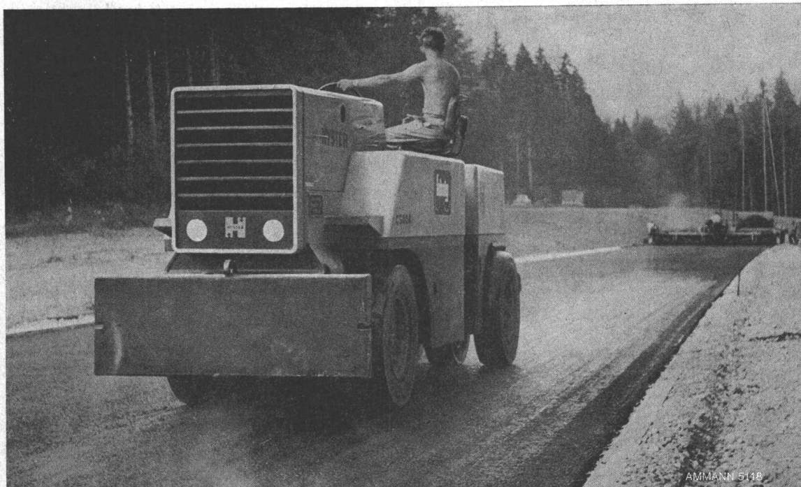
Tragschichtverdichtung auf der N1 bei Hindelbank mit der HYSTER-Pneuwalze Modell C 500 A
