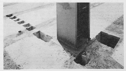
Bild 6. Aussparungen im Stützenbereich. Flaschengeschäft der Brauerei Haldengut in Winterthur. Kellerdecke mit Spannweiten  $8.8\times8.8$  m und einer Nutzlast von 2 t/m²
