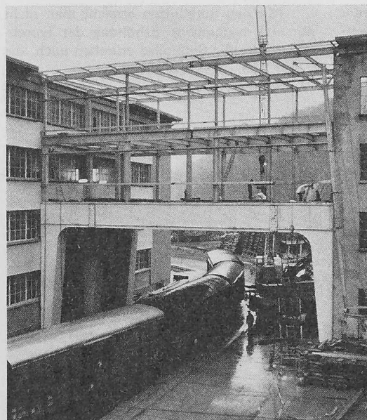
Bild 12. Drei Fünftel der Konstruktion sind montiert
