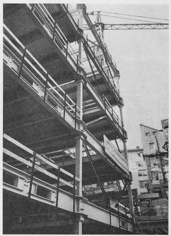
Fig. 4. Etages de superstructure. A noter les colonnes carrées en acier forgé et les chapiteaux
