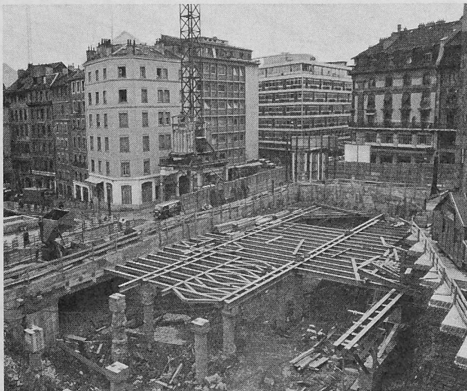
Fig. 1. Le début du chantier. Les têtes des pieux provisoires sont dégagées. On poursuit les terrassements de droite à gauche. La charpente métallique est posée et mise en charge en suivant (juin 1964)
