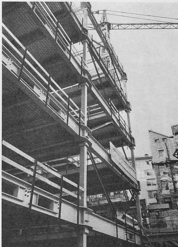
Fig. 4. Etages de superstructure. A noter les colonnes carrées en acier forgé et les chapiteaux
