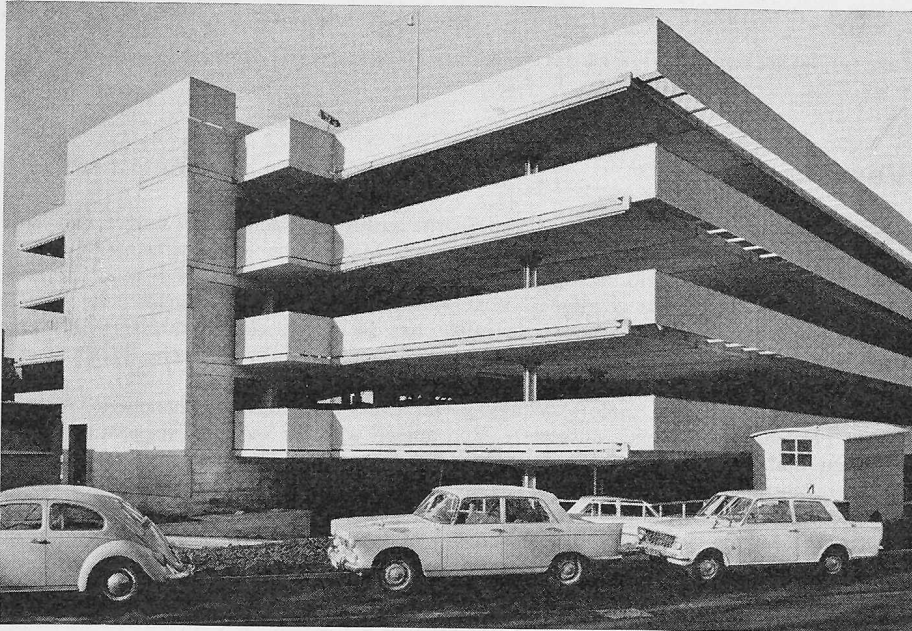
Bild 1. Parkhaus Sihlquai, Zürich: Vorfabriziertes, zerlegbares Provisorium (Ing. M. R. Roš, Zürich)
