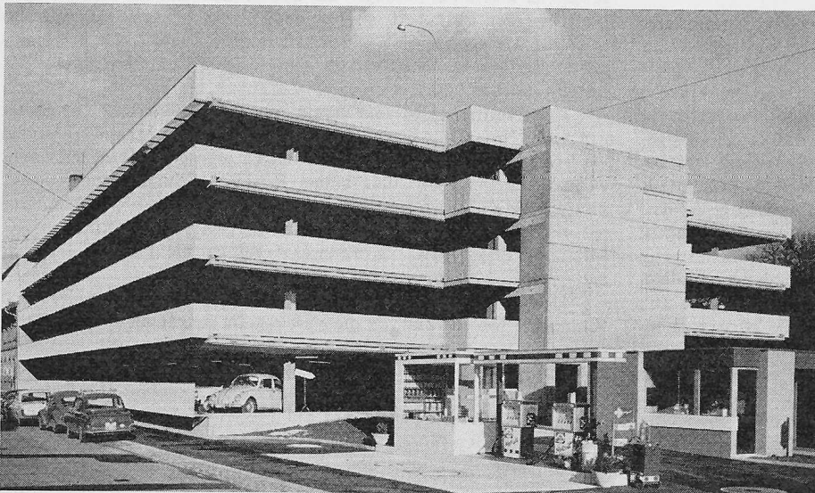
Bild 2. Parkhaus Sihlquai, Zürich: Stahlstützen und vorgefertigte Betonelemente
