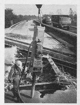
Bild 1, Felsbrecher VR 15 A beim Abbruch der alten Fahrbahndecke, während auf der Gegenfahrbahn der Verkehr unbehindert weiterrollt
