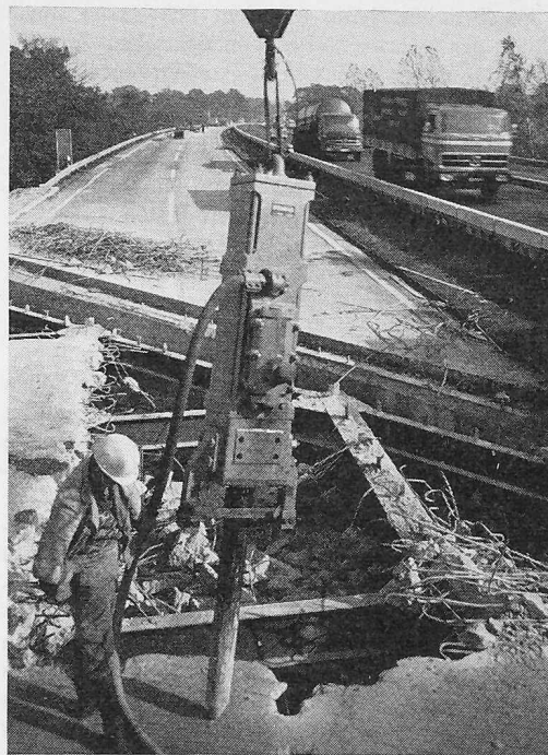
Bild 1. Felsbrecher VR 15 A beim Abbruch der alten Fahrbahndecke, während auf der Gegenfahrbahn der Verkehr unbehindert weiterrollt
