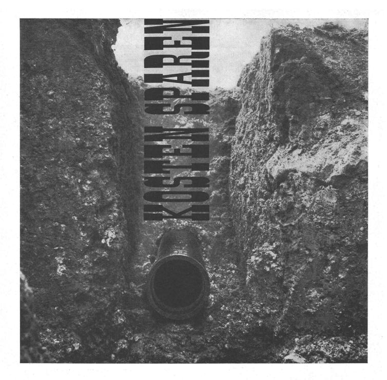
Bekanntlich kennt man beim KEY-Rohr kein Einbringen einer Dichtung und in neun von zehn Fällen erübrigt sich das Erstellen eines Fundamentes. Wegen des Wegfallens dieser Arbeitsgänge genügt somit für die Verlegung von KEY-Rohren ein schmaler Graben — also geringer Aushub, Einsparung von Kosten!
