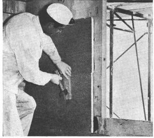
SCHICHTEX 35/III als Innenisolation auf Betonelement aufgeklebt
