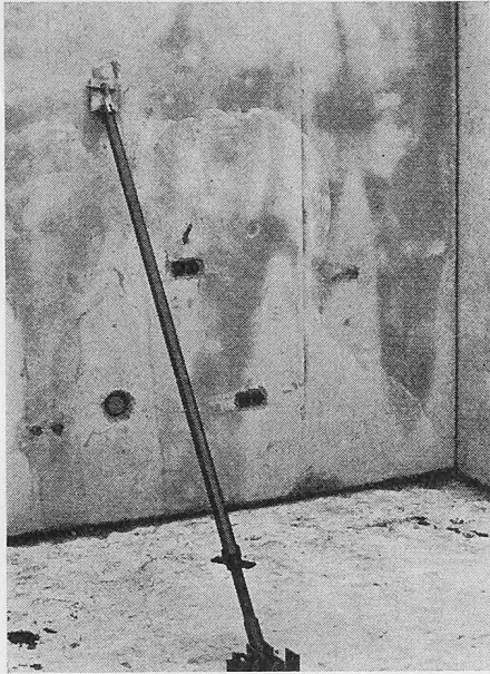
Bild 2. Zwischenwandplatten mit tapezierbereiter Oberfläche und Installationseinlagen. Abstützen und justieren mit Hilfe von Teleskopstieben (System Peikert)
