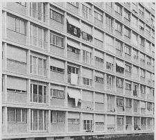
Bild 13. Im Werk fertig verglaste Fensterpartie mit Konvektoren, Heizsteigleitung konventionell (System Igeco)
