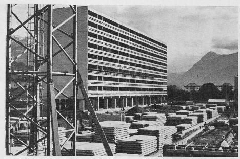
Bild 7. Feldfabrik und Lagerung auf der Baustelle der «Cité Parc» in Aigle (System Tracoba; Ausführung: Préfabrication Industrielle du Bâtiment S. A., P. I. B., Chéserex sur Nyon)
