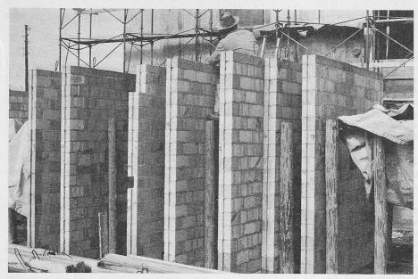
Bild 12. Lagerung der im Werk fabrizierten «Preton»-Wände auf einem Bauplatz in Worblaufen-Bern
