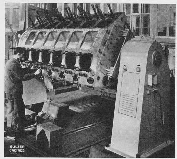
Bild 23. In den Montagegestellen eingespannter Zylinderblock
