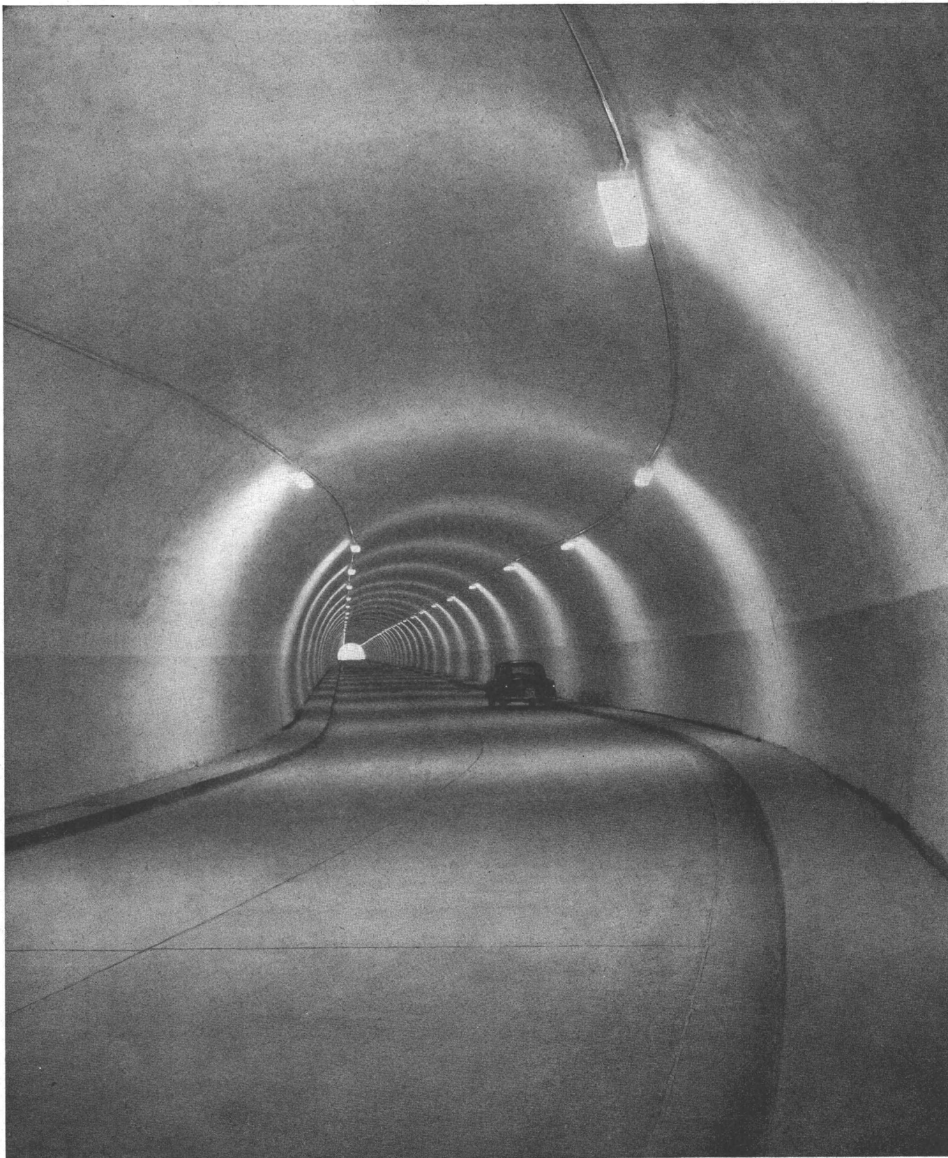
N 13 Bernhardin-Passtrasse, Betonbelag im Tunnel bei Rongellen
