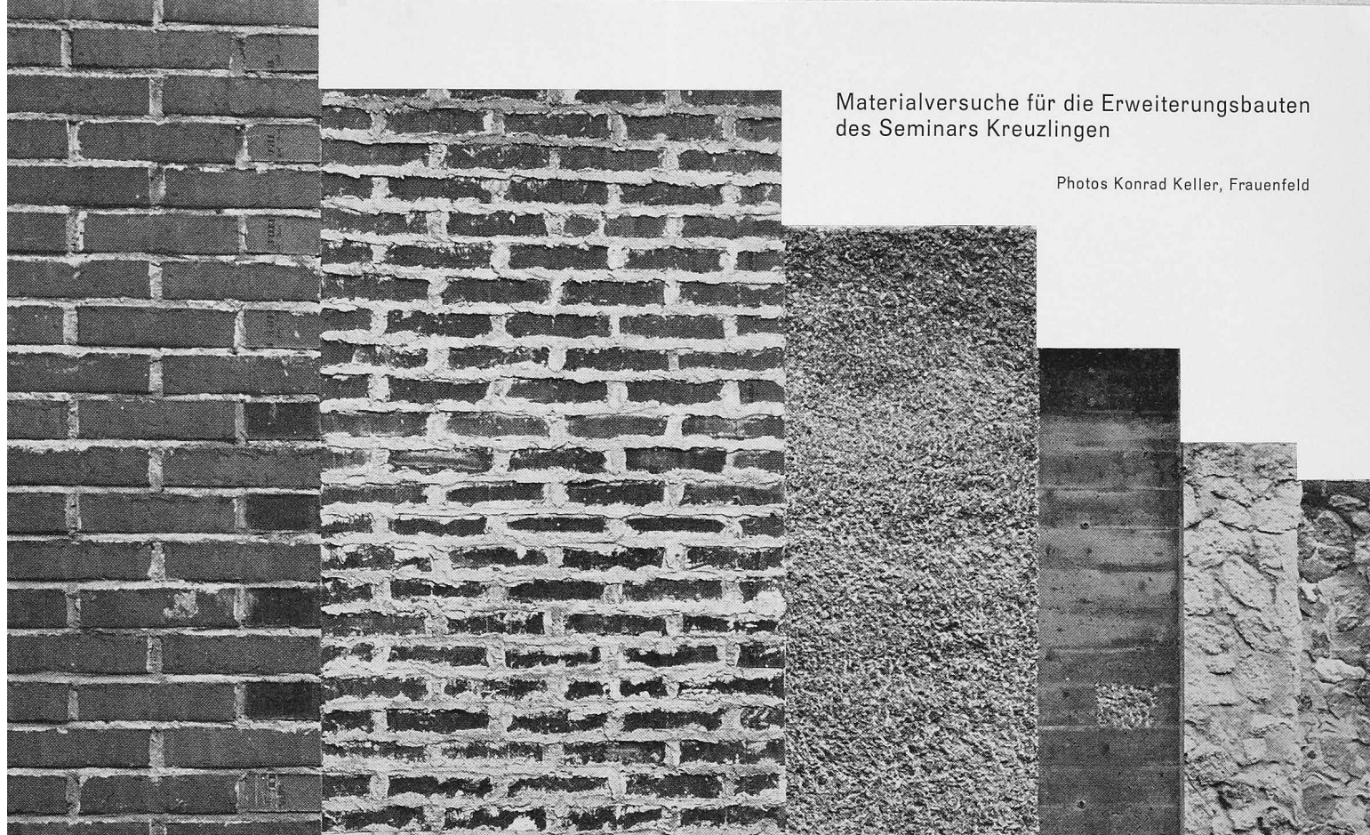
Bild 1. Gesamtansicht der 3 m hohen Materialmuster. Von links nach rechts: Backstein mit abgezogenen Fugen, Backstein mit verstrichenen Fugen, gespitzter Beton, eingefärbter Beton, Injektionsbeton mit Tengener-Muschelkalk, Injektionsbeton mit Murger-Sernifit
