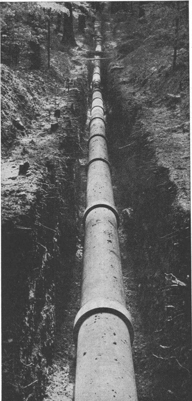
Asbestzement-Rohre «ETERNIT» für Wasserversorgungen. Seit fünfzig Jahren bewährt. Lange Lebensdauer. Widerstandsfähig gegen Korrosion und chemische Einflüsse. Leicht zu transportieren, einfach zu verlegen. Daher wirtschaftlich.
