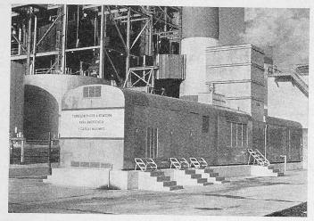
Bild 3. Eine der vier 10-MW-Block-Gasturbinengruppen mit Flugzeug-Düsentriebwerken als Treibgaserzeuger, bei der Puerto Rico Water Ressources Authority (P. R. W. R. A.), Puerto Rico
