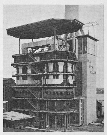
Bild 24. Die Gasturbinenanlage Oberhausen von 13 MW. Vorn der kohlenstaubgefeuerte Lufterhitzer, hinten das Maschinenhaus
