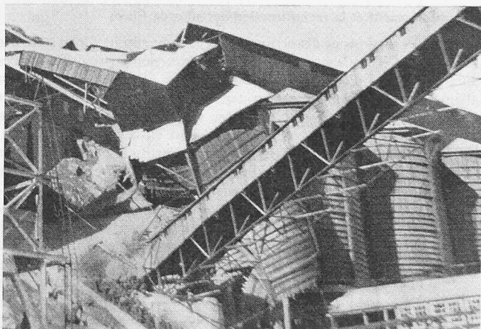
Fig. 3. Les silos de Blava immédiatement après l'accident du 8 octobre 1953
