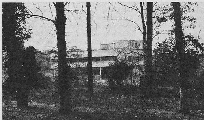
Villa Savoie von Westen gesehen (heutiger Zustand)
