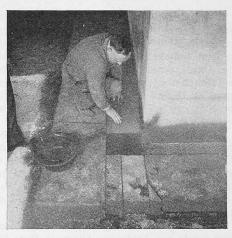
Verlegen, Eingiessen und Isolieren der Heizmatten in einem Kühlhaus.
