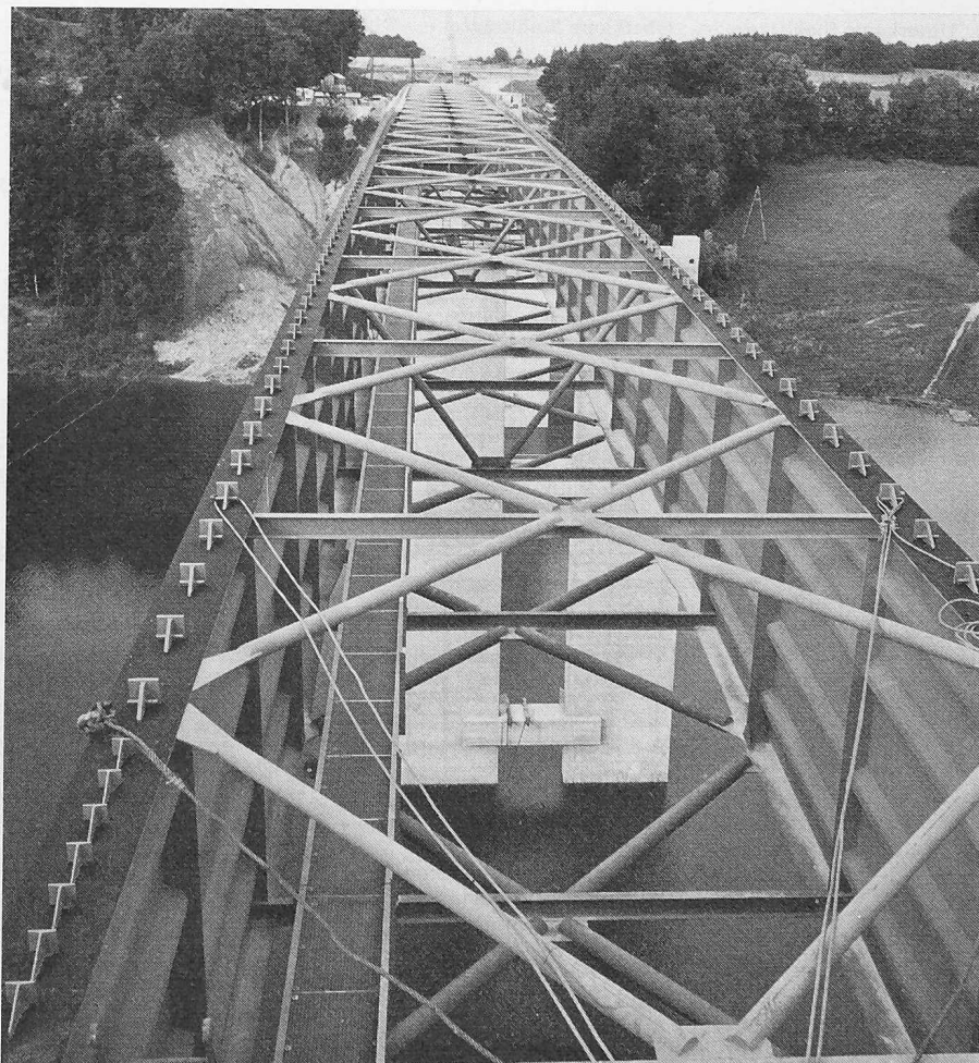
Bild 8. Draufsicht nach Abschluss des Einschlebens, vom linken Widerlager aus aufgenommen. Die Anordnung der Windverbände und die Dübelverteilung sind gut sichtbar
