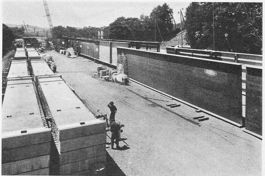
Bild 14. Zusammenbau der Hauptträger. Im Vordergrund einige Fertigplatten
