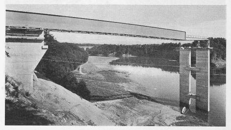
Bild 15. Abschluss der ersten Etappe des Einschiebens (Kragarmlänge 90,80 m, max. Durchbiegung der Schnabelspitze rd. 160 cm)
