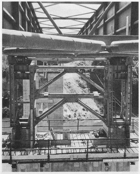
Bild 17. Pfeileraufbauten mit den Rollenbatterien beim Einschieben
