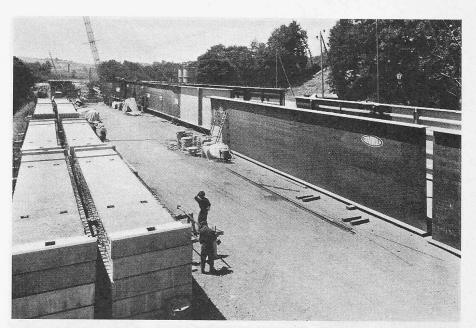
Bild 14. Zusammenbau der Hauptträger. Im Vordergrund einige Fertigplatten
