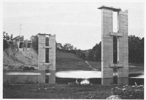
Bild 22. Fertige Pfeiler zu Beginn des Aufstaus
