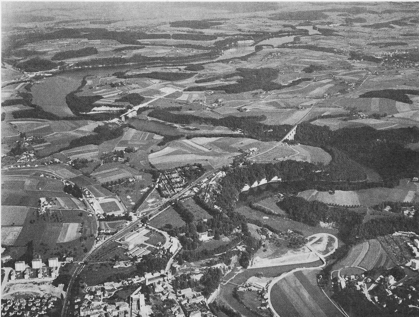
Bild 1. Flugbild des Saanetales unterhalb Freiburg. In Bildmitte rechts der Grandfey-Viadukt der Eisenbahnlinie Freiburg–Bern, links die neue Autobahnbrücke bei der Montage. Auf dem rechten Ufer ist der Installationsplatz sichtbar
