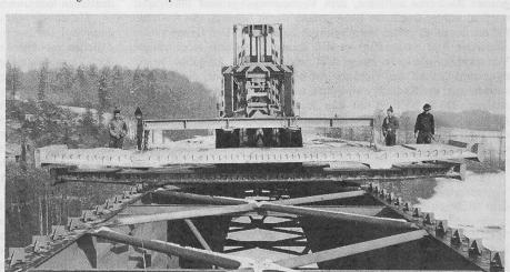
Tag verlegt werden. Kritisch dabei war allerdings das Überfahren der noch nicht geschlossenen Fugen mit der Achslast von über 30 t. Durch Unterlegen von Holzschwellen musste dafür gesorgt werden, dass sich die Last stets auch auf die Nachbarplatten übertrug, damit keine zu grossen Durchbiegungsdifferenzen auftraten.
