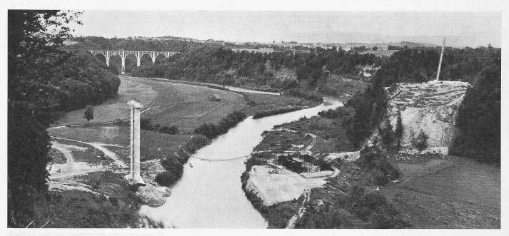
Bild 2. Die Baustelle flussaufwärts gesehen, während der Erstellung der Pfeiler und Widerlager. Die Saane ist noch nicht aufgestaut
