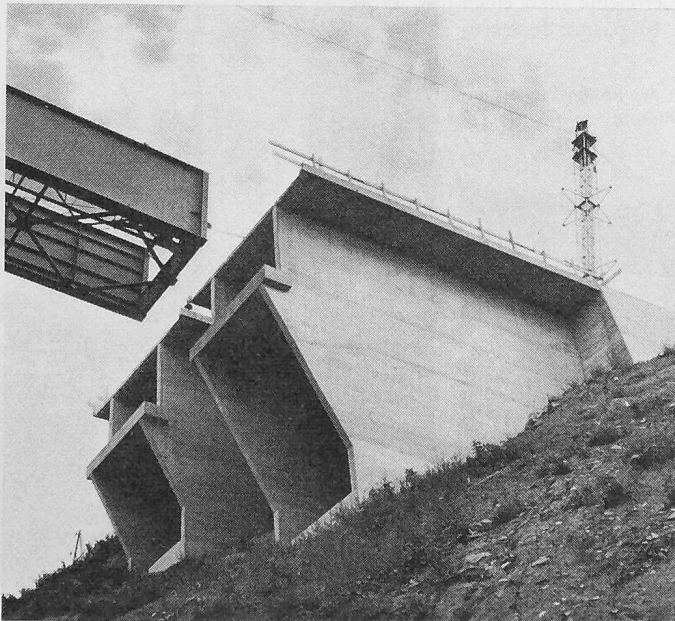
Bild 23. Widerlager auf der linken Talseite. Die Stahlträger werden eingeschoben und erreichen das Widerlager
