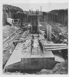
Bild 21. Aufbau eines Pfeilers mit Gleitschalung
