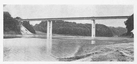
Bild 29. Bild der fertigen Brücke. Es fehlen noch die Belagsarbeiten und die Leitplanken
