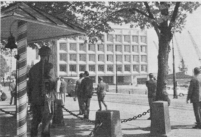
Bild 7. Geschäftshaus Enso Gutzeit am Hafen von Helsinki. Merkwürdige Koexistenz in einem und demselben Gebäude von schemenhafter, zweckgebundener Architektur und von klassisch gefärbter, aber lässig angewendeter Monumentalität
