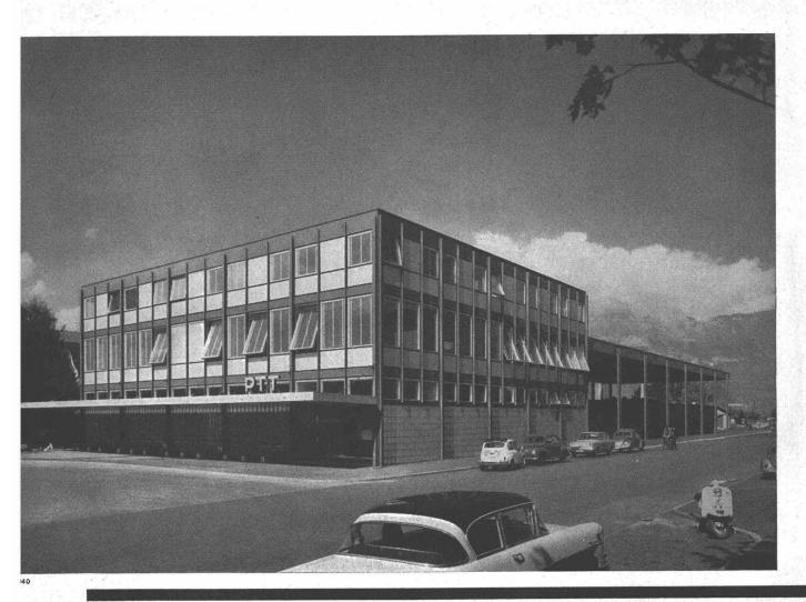
PTT-Betriebsgebäude Buchs/SG dipl. Architekt W. Gantenbein, Zürich und Buchs Sichtbare unverkleidete Stahlkonstruktion Fassadenstützen aus I-Profilen Sturzträger aus gepressten Blechen
