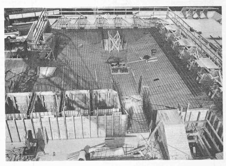
Bild 5. Armierung der unteren Traggeschoss-Platte
