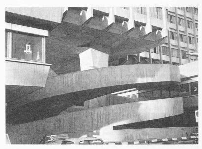
Bild 18. Die fertigen Rampen zum zweiten Obergeschoss (oben Auffahrt, unten Abfahrt)
