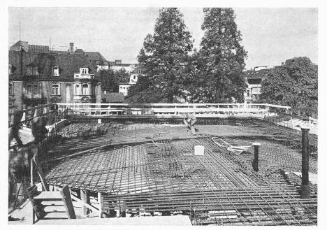
Bild 6. Armierung der oberen Traggeschoss-Platte und Vorspannkabel
