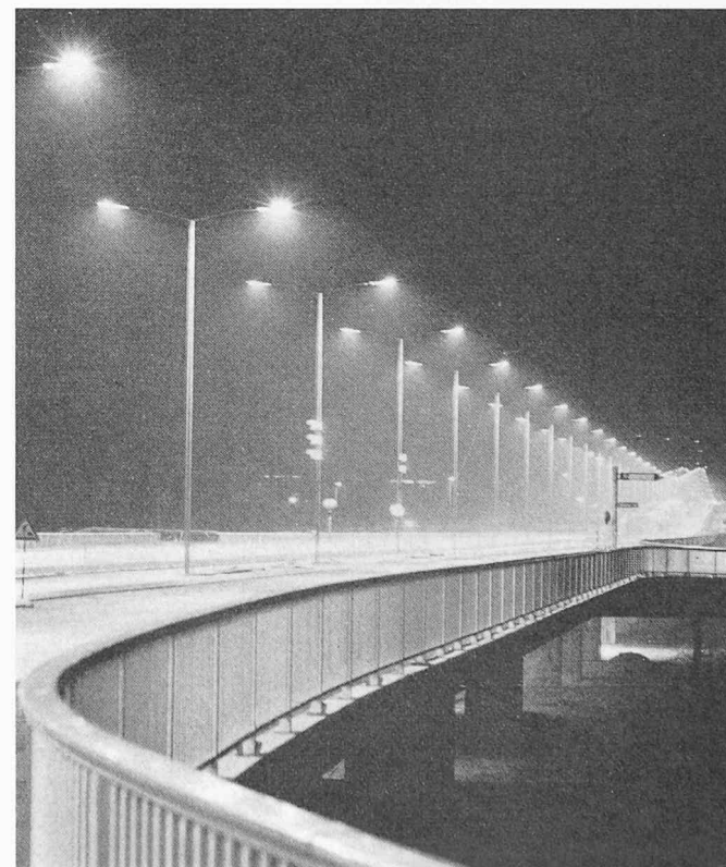
Bild 7. Versuchsstrecke der Firma «Novelectric» in Buchs-Dällikon. Quecksilberdampflicht mit Halogenen im Brenner, extrem hohe Strassenbeleuchtung 85 lx, Personenwagen Volvo mit Abblendlicht. Infolge kurzer Belichtungszeit ähnliche Wirkung wie auf das menschliche Auge. Die Blendwirkung des Abblendlichtes wird durch die hohe Strassenbeleuchtungsstärke wesentlich gemildert
