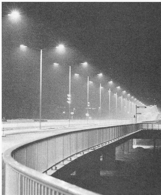
Bild 5. Europa-Brücke in Zürich. Hochliegende, 2 x zweispurige Verbindung der Quartiere Altstetten und Höngg. Beleuchtung mit Quecksilberdampflicht (mit Leuchtstoffmantel, weisses Licht), mit vorläufig 1 x 250-W-Lampen bestückt, 14 lx, ausbaubar auf 2 x 250 W
