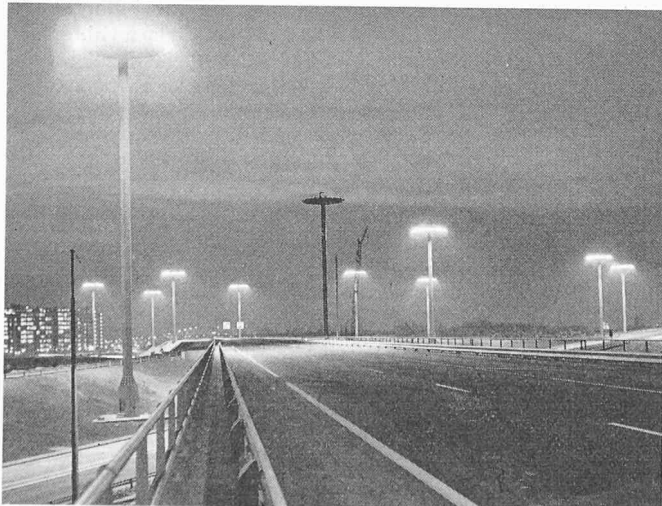
Bild 4. Brienoord-Verzweigung in Rotterdam. Pro Mast 24 Natriumdampflampen 200 W, mittlere Beleuchtungsstärke 50 lx
