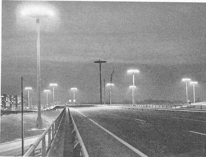
Bild 4. Brieneoord-Verzweigung in Rotterdam. Pro Mast 24 Natriumdampflampen 200 W, mittlere Beleuchtungsstärke 50 lx
