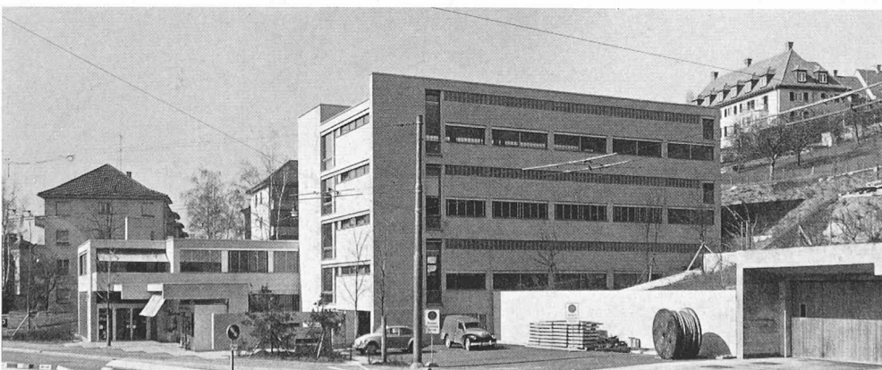
Post- und Telefongebäude Zürich-Hirslanden Bauherr: Direktion der eidgenössischen Bauten, Bern Architekt: Paul W. Tittel (Oberbauleitung: Eidg. Bau- inspektion IV, Zürich)
