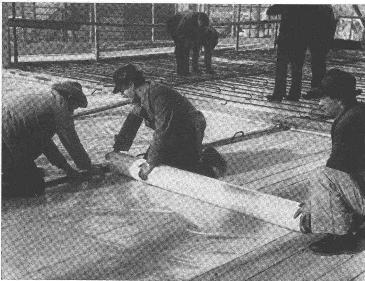
Polyäthylen «Howagaine» im Strassenbau
