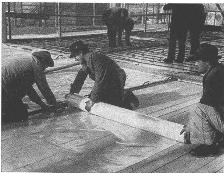
Polyäthylen «Howagaine» im Strassenbau
