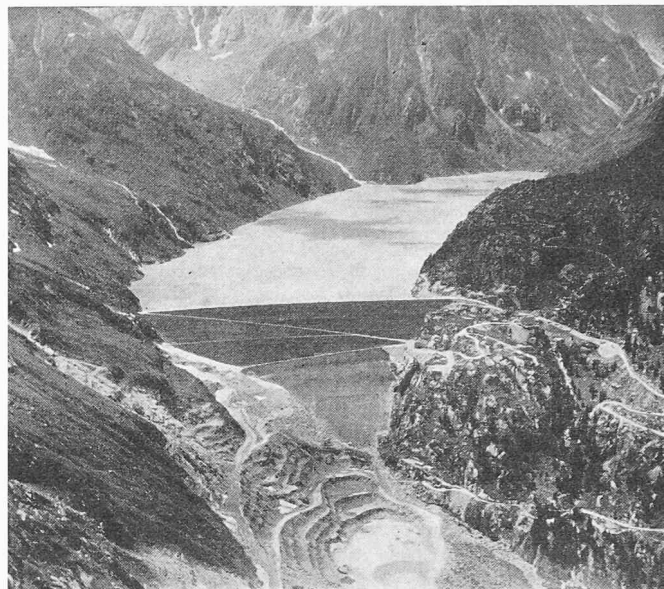
Bild 3. Flugaufnahme des Staudammes Göschenalp (Foto Swissair)
