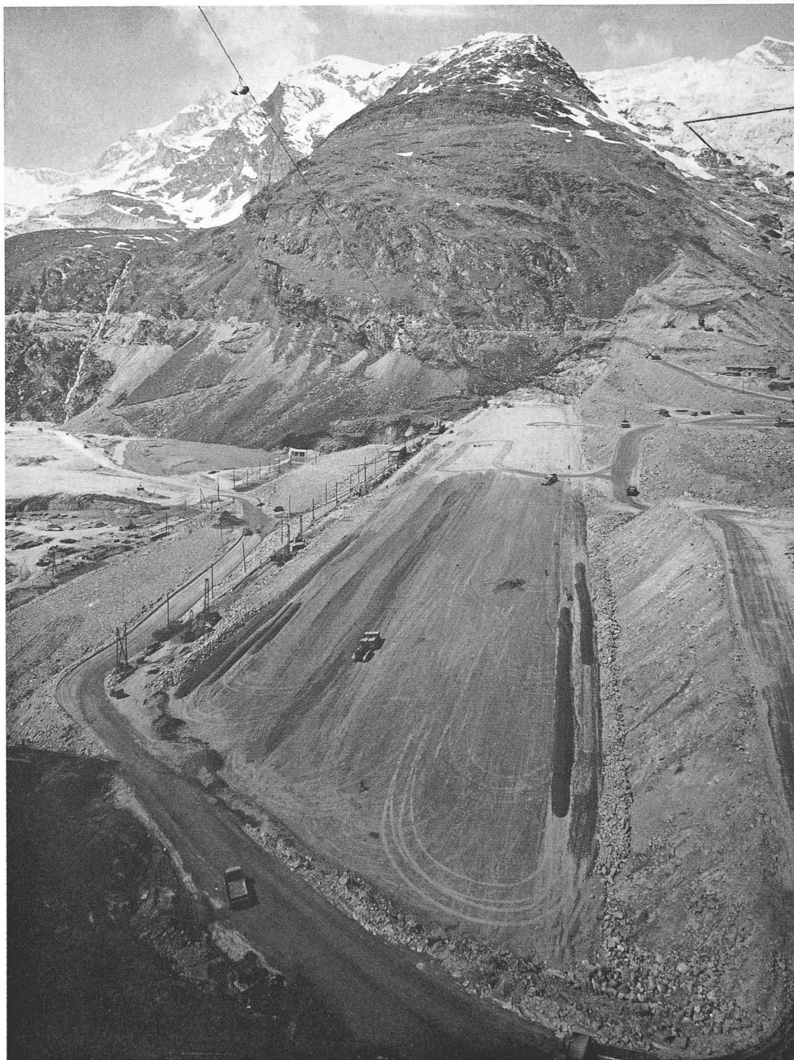
Bild 7. Der Staudamm Mattmark im Bau — Juni 1965. Links das zukünftige Staubecken, in Bildmitte der Kerneinbau, rechts der luftseitige Stützkörper und am oberen Bildrand der Allalingletscher mit Angabe der Abbruchstelle vom 30. August 1965 (schwarzer Strich)
