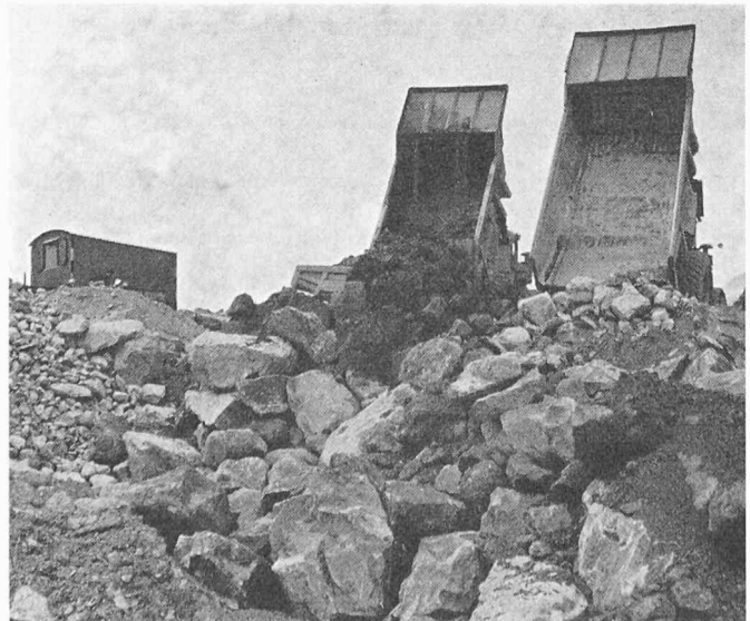
Bild 8. Einbau des Stützkörpers im Staudamm Mattmark (Foto der Elektro-Watt)
