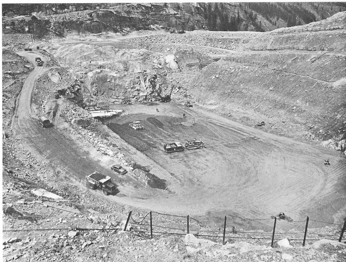
Bild 5. Der Kerneinbau in der bis auf den Fels ausgehobenen Baugrube des Staudammes Göschenalp
