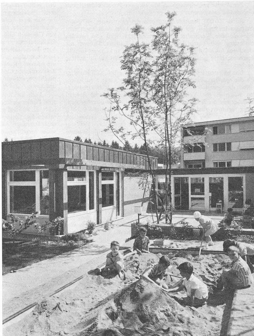
Blick von Südwesten gegen Kindergarten (links) und Garderobetrakt
